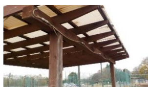
スポーツ施設におけるミストシャワーの設置（左：市民野球場、右：調布基地跡地運動広場）
