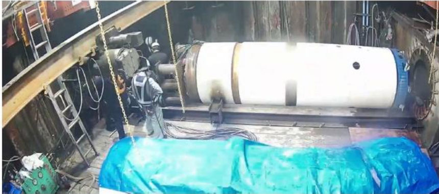
掘削口に向かって掘削を開始
