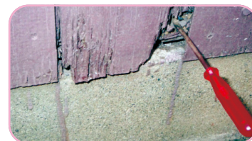
土台の腐朽度合いを調査
