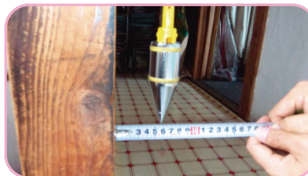
下げ振りで柱の傾きを調査
