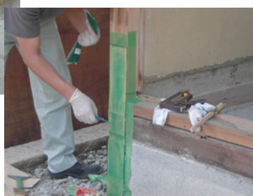
柱脚補強 (70cmシート1枚貼り)
