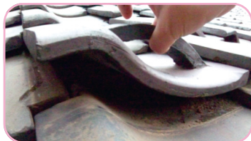
屋根瓦の葺き土の有無を調査
