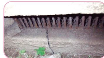
基礎のひび割れを調査
