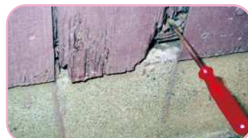
土台の腐朽度合いを調査
