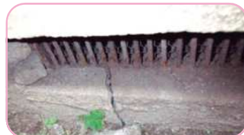
基礎のひび割れを調査
