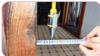
下げ振りで柱の傾きを調査
