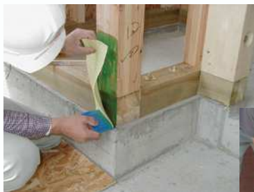
柱脚補強 (30cmシート1枚貼り)
