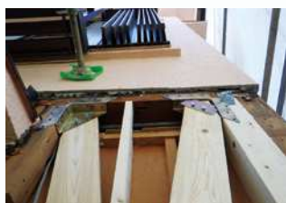
通し柱補強（室外より）
