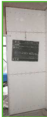
③パネルの施工
