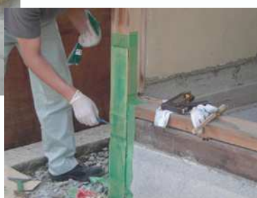
柱脚補強 (70cmシート1枚貼り)
