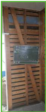
①既存壁の撤去
