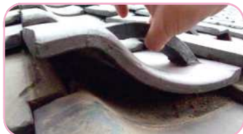
屋根瓦の葺き土の有無を調査
