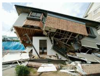
倒壊実験写真
