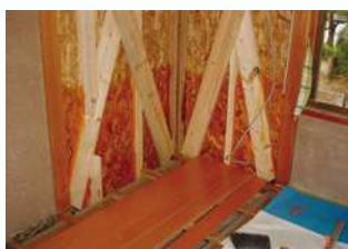
押入れ内補強
