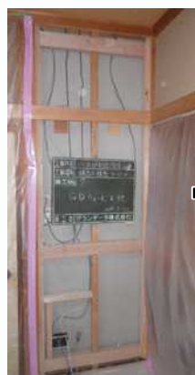
合板受材施工
