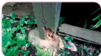
柱脚の腐朽を調査
