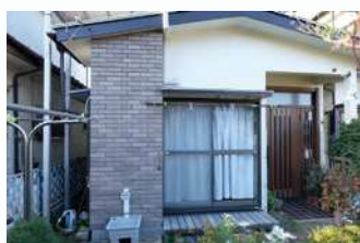
フレーム完成
