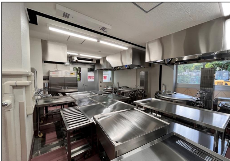
No.2 調布市立多摩川小学校給食室改修工事 厨房機器 設置状況
