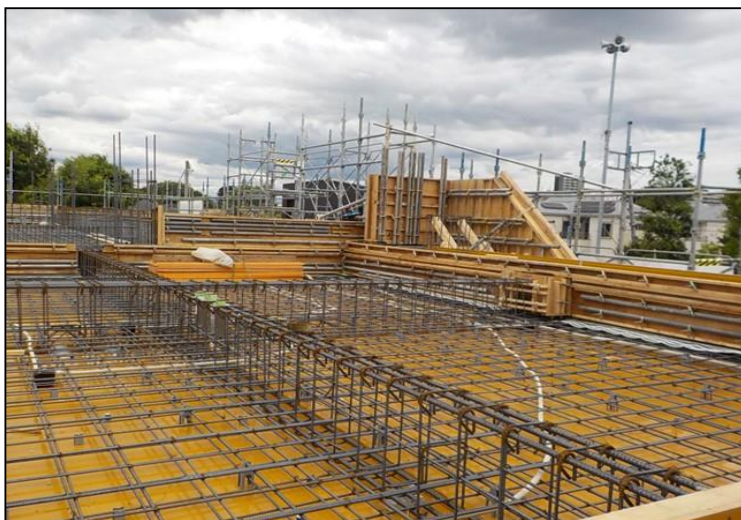
No.3 (仮称)調布市国史跡下布田遺跡ガイダンス施設新築工事 1階躯体 施工状況
