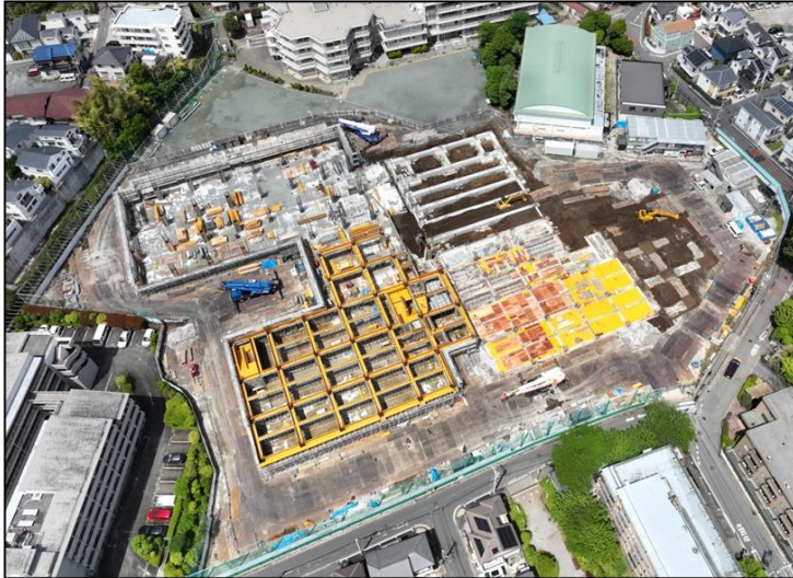
No.1 調布市立若葉小学校・第四中学校・ 図書館若葉分館施設整備PFI事業 基礎、地上1階躯体 施工状況
