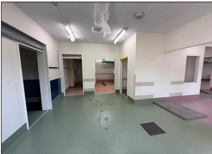
No.2 調布市立多摩川小学校給食室改修工事 内装仕上 施工状況
