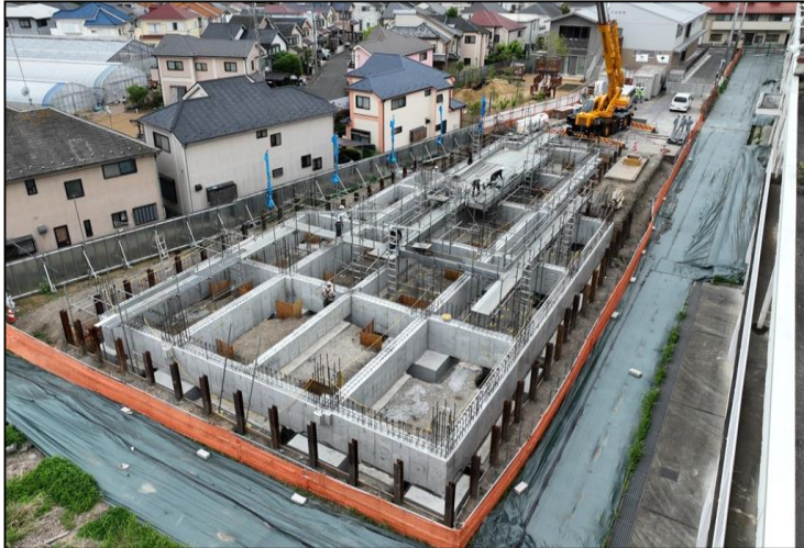
No.4 調布市立図書館宮の下分館改築工事 基礎 施工状況
