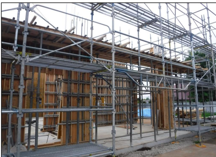
No.3 （仮称）調布市国史跡下布田遺跡ガイダンス施設新築工事 1階躯体 施工状況
