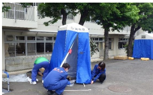
▲避難所開設訓練（マンホールトイレ設置） （富士見台小学校）
