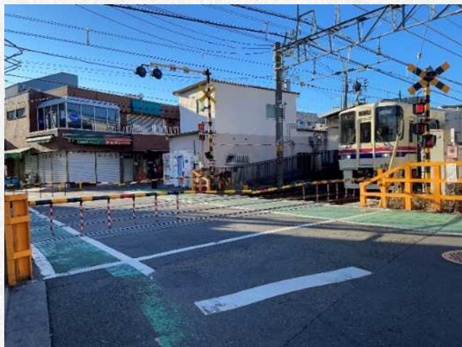
つつじヶ丘5号踏切 誘導ブロック 設置前
