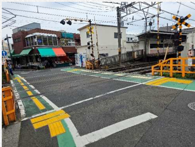
つつじヶ丘5号踏切 誘導ブロック 設置後
